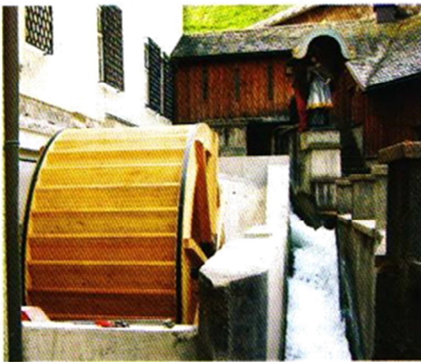
Abb. 1: Wasserrad beim Einbau noch vor der Inbetriebnahme ohne die spätere Überdachung
